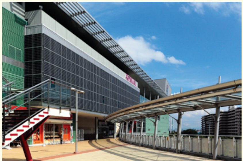
写真④ イオンモール伊丹 太陽光パネル
