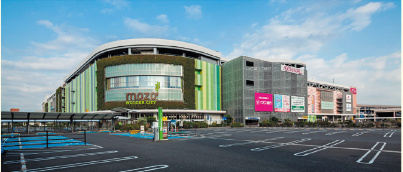
写真① mozoワンダーシティ 外観
